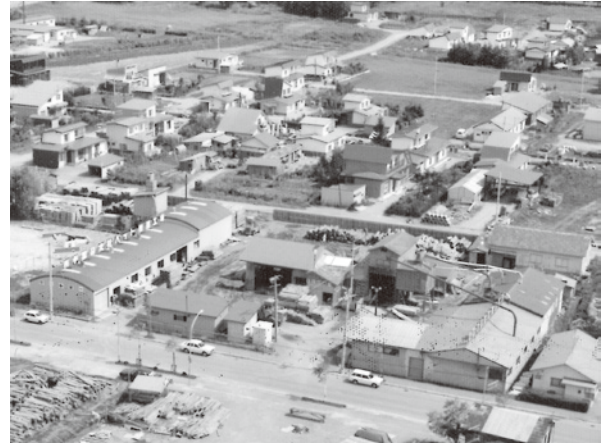
図7 福沢製作所全景(資料番号2020-294の一部)
