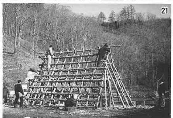
頂上部の高さを調整した。垂木は、結局約5mの長さのところに約55cm間隔で9本掛けた。
