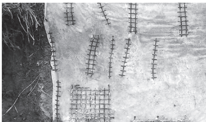
写真10 プラスチック製シートによる補強
