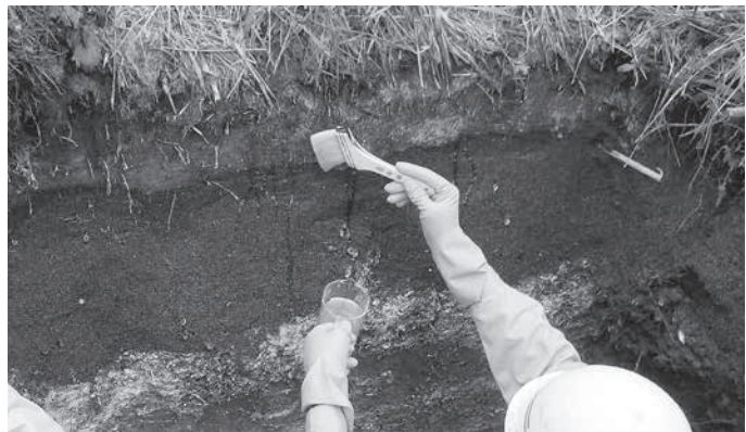
写真4 2回目の合成樹脂の塗布（刷毛を使用）
