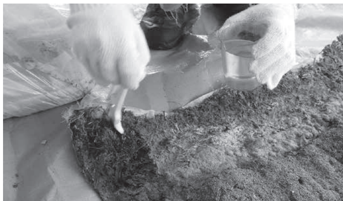
写真11 調合したサンコールSK50の塗布
